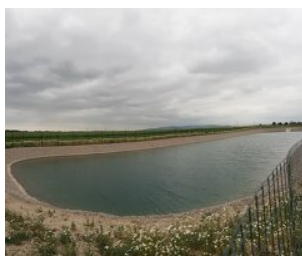
Abteilung Wasserbau (WA3) Amt der NÖLR
