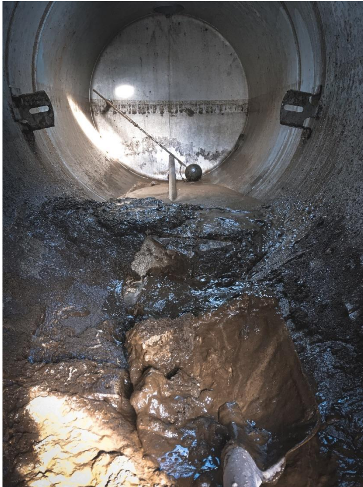
Kalk-Gülle-Gemisch am Boden des Vorlagebehälters und Ablöschen des gekörnten Kalks: © LK Steiermark, P. Zenger
